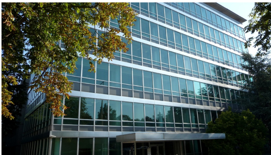
Abb. 3 Fassade Bürogebäude 1030 Wien, Baujahr 1962/1963, Originalzustand, Architekt G. LIPPERT
